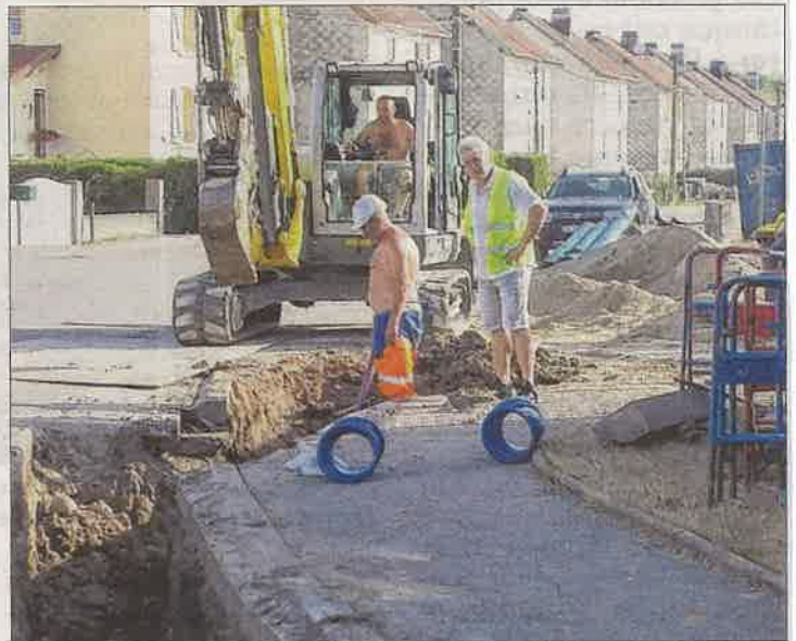
Le chantier de changement de conduite arrive au stade à Uxegney.
