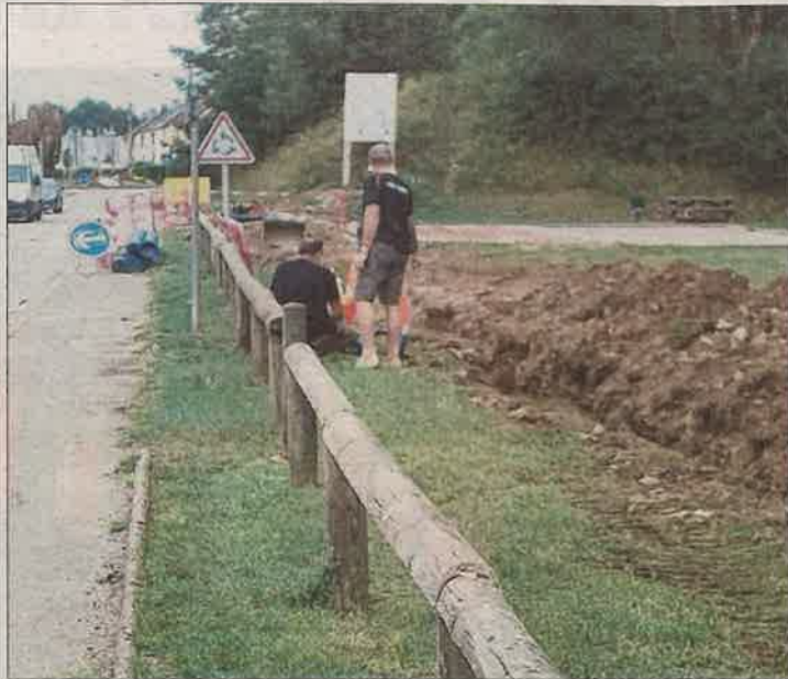
Le chantier se termine le long du terrain de bosses et une dernière traversée de rue est prévue pour le raccordement au réseau existant.
