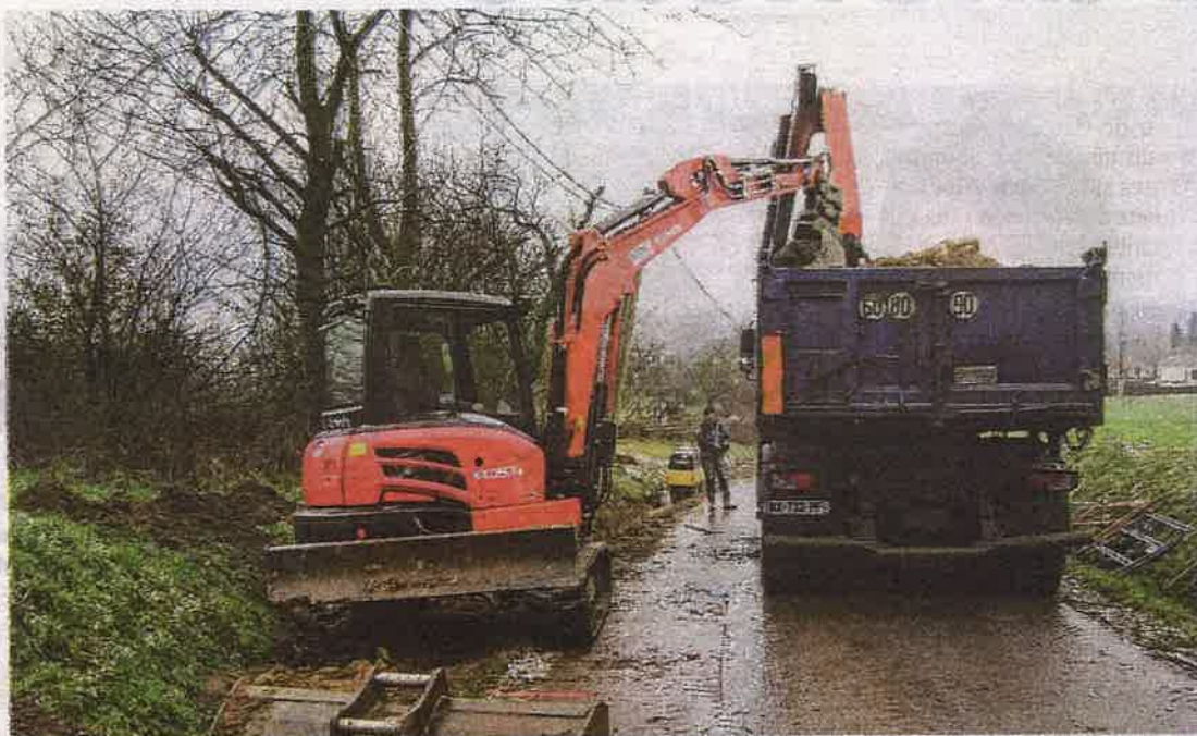
Pour sécuriser la distribution d'eau, 500 mètres de conduite toute neuve ont été posés entre la rue des Pins et la route de Darney à Chaumousey.
