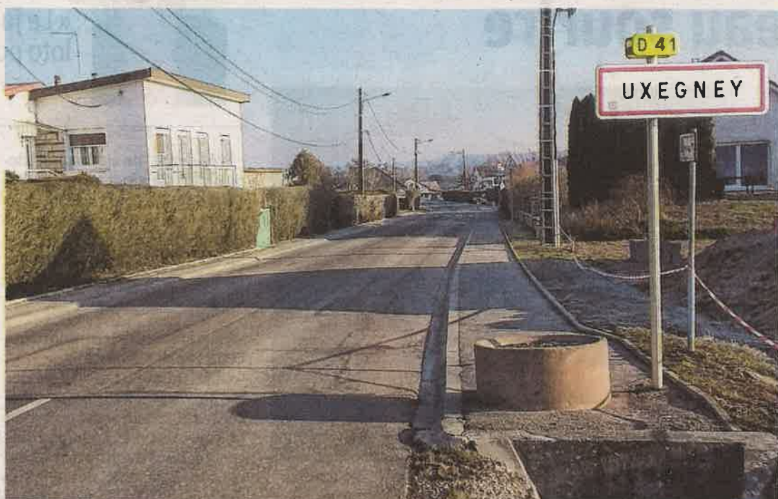
Le chantier de 3,200 km mené par le syndicat des eaux de l'Avière passera par la route de Sanchey à Uxegney.
